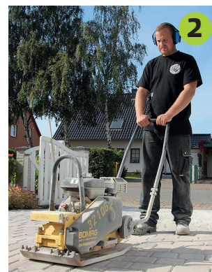
Vibrer – à partir d'une profondeur de joint de 2 cm
